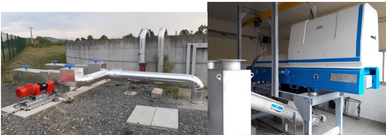
Figure 30 : Travaux de la station d'épuration de St Etienne des Oullières
